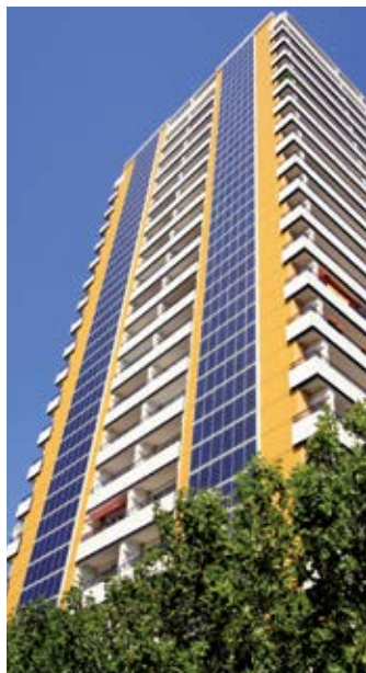
Die Fassade eines der drei Doppelwohnhochhäuser am Helene-Weigel-Platz ist mit innovativer Photovoltaiktechnologie ausgerüstet.
